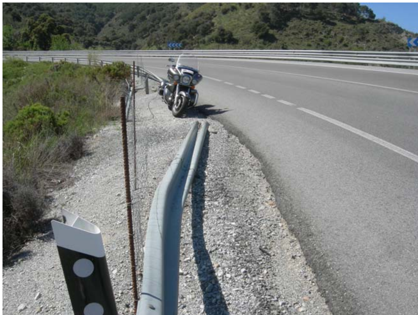
Zona kilómetro 8,800. Sentido Sierra Nevada.
