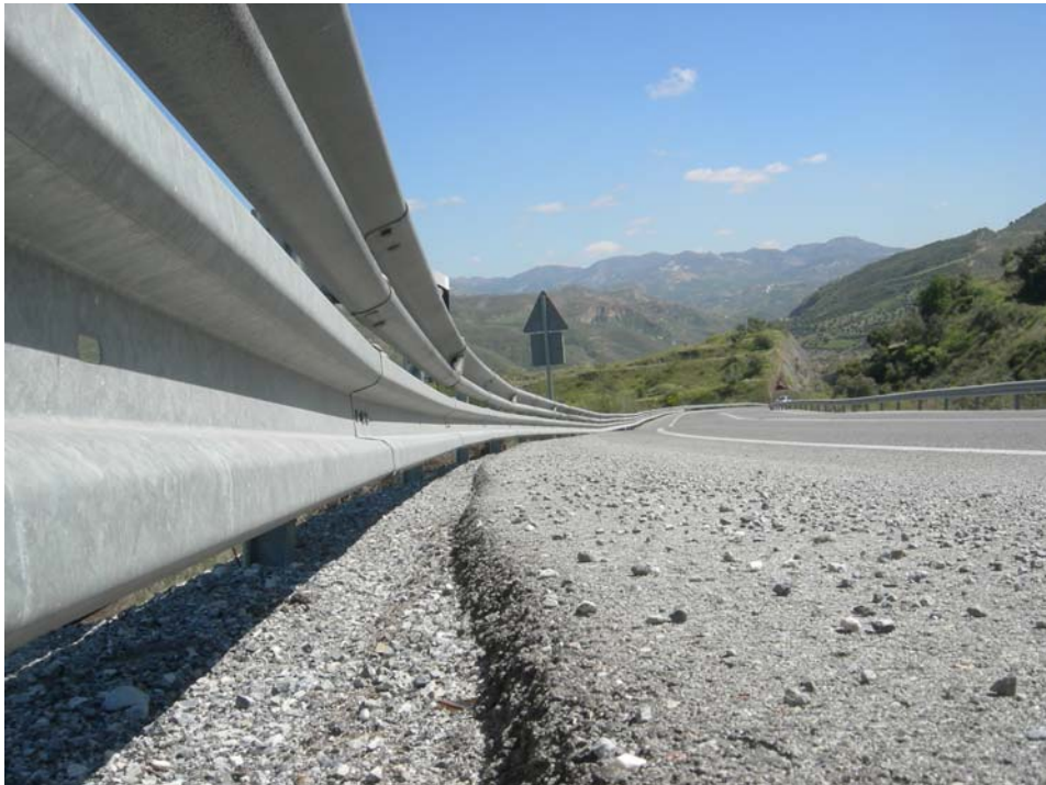
Fotografía 005. Áridos en la parte transitable del arcén.
