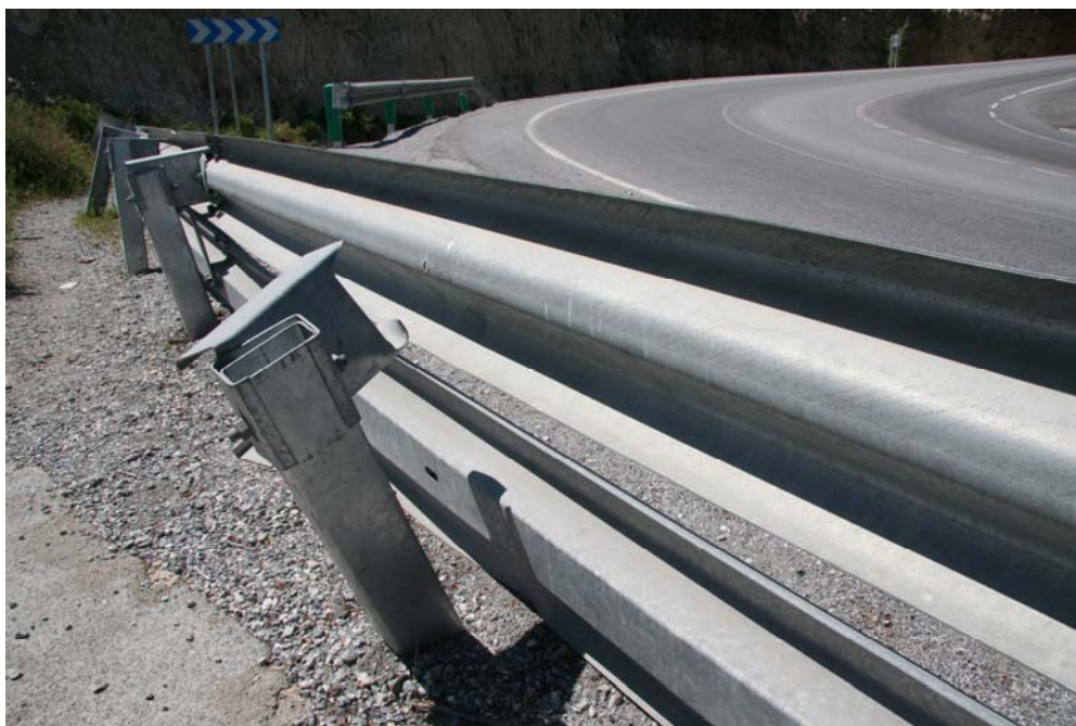
Fotografía 26. Presencia de deformaciones graves.
