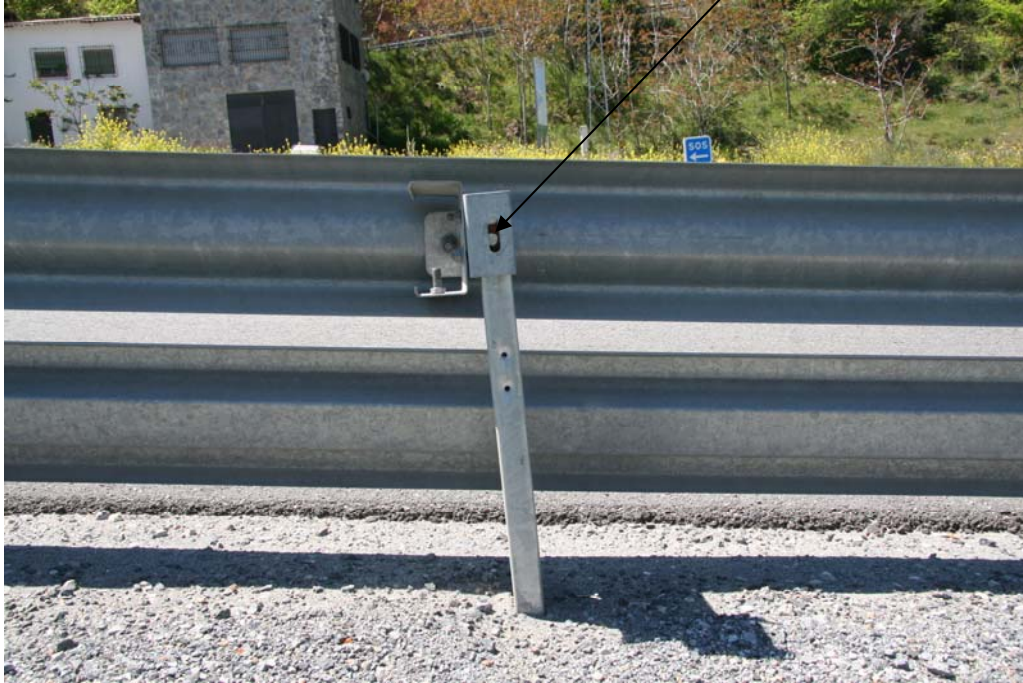
Fotografía 28. Otro ejemplo de la carencia de tornillería del sistema base "barrera metálica de seguridad".
