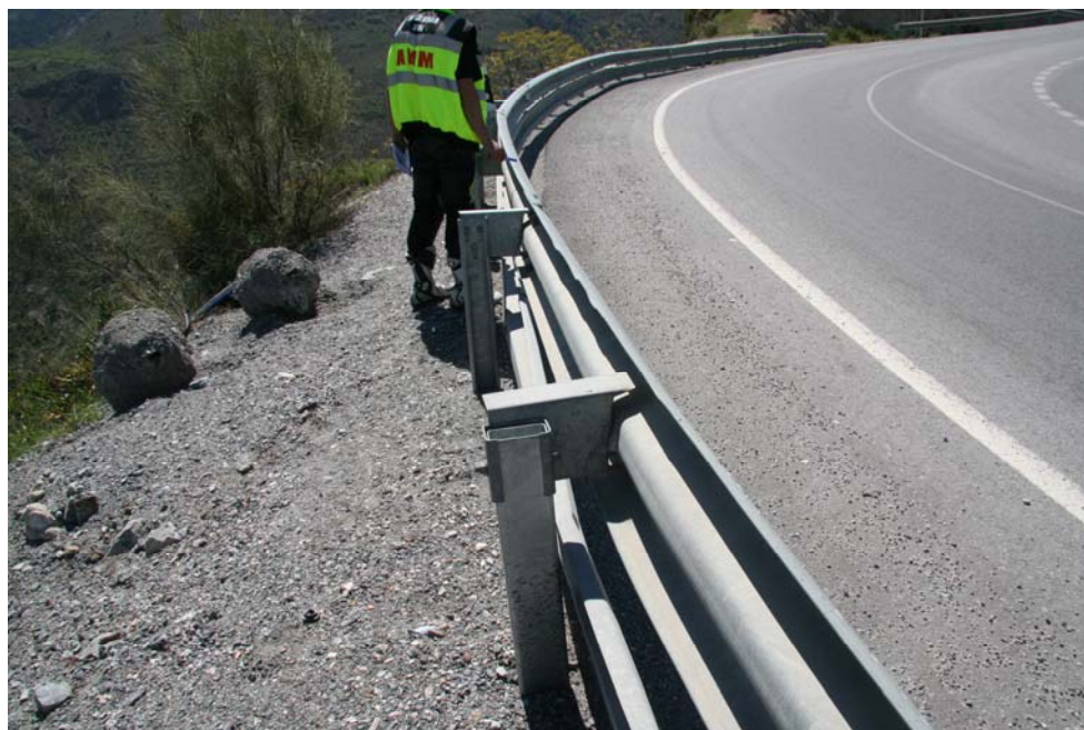
Fotografía 30. Combinación con poste tubular y poste tipo "C".
