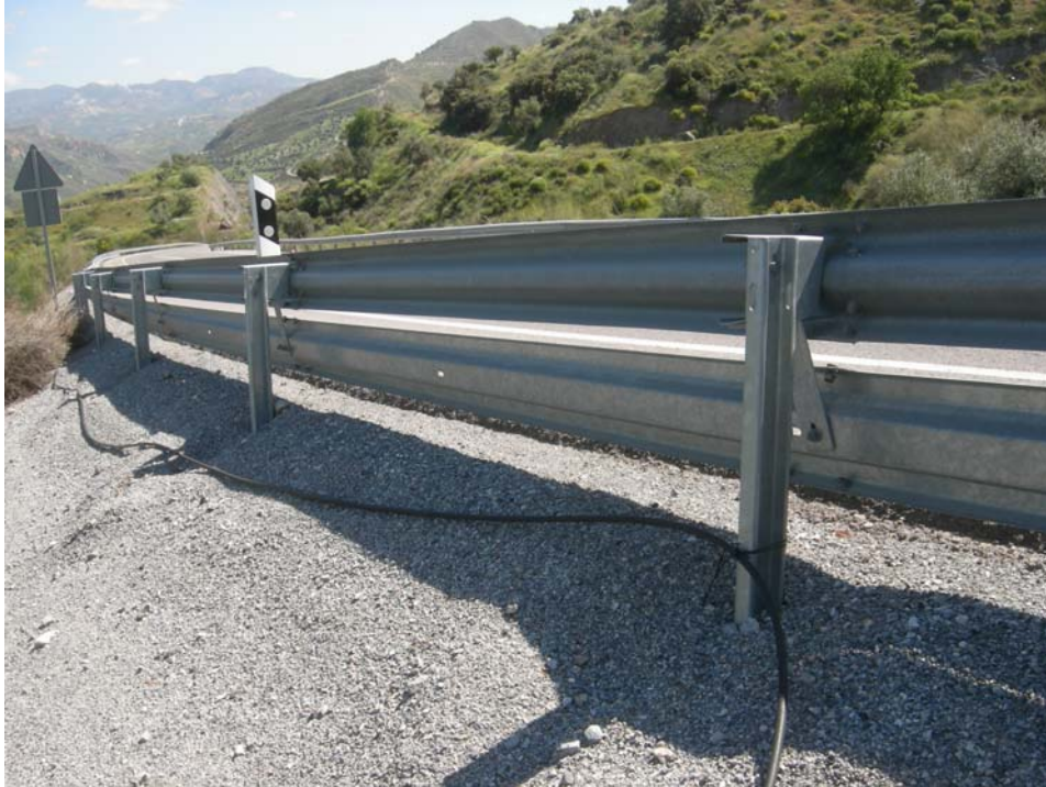
Fotografía 005. Áridos en la parte transitable del arcén.
