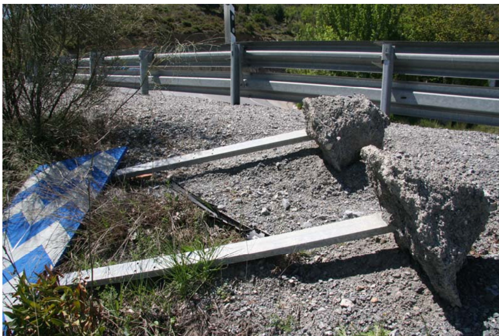
Fotografía 32. Situación de un panel direccional. Ejemplo de mantenimiento.
