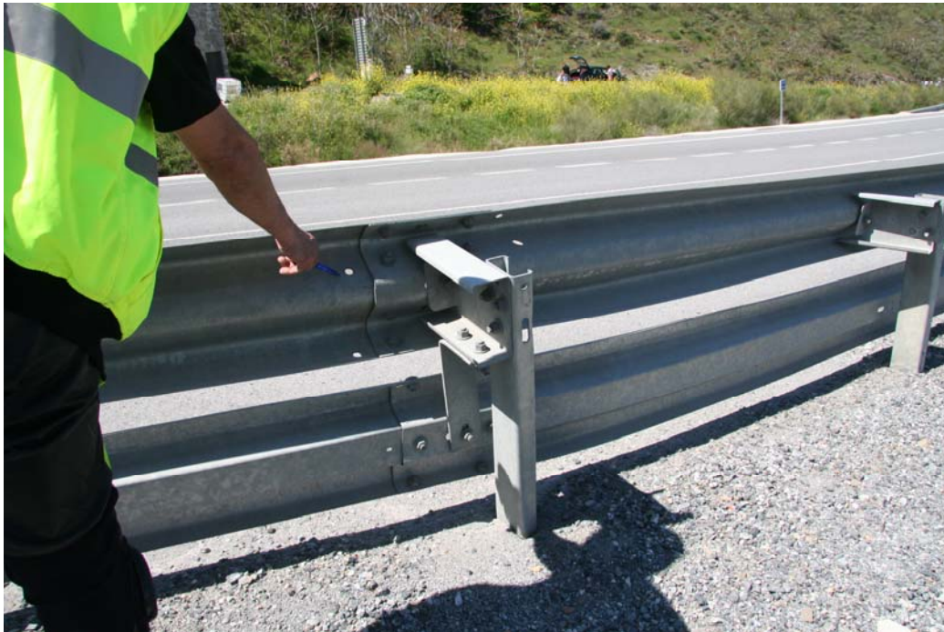
Fotografía 28. Otro ejemplo de la carencia de tornillería del sistema base "barrera metálica de seguridad".
