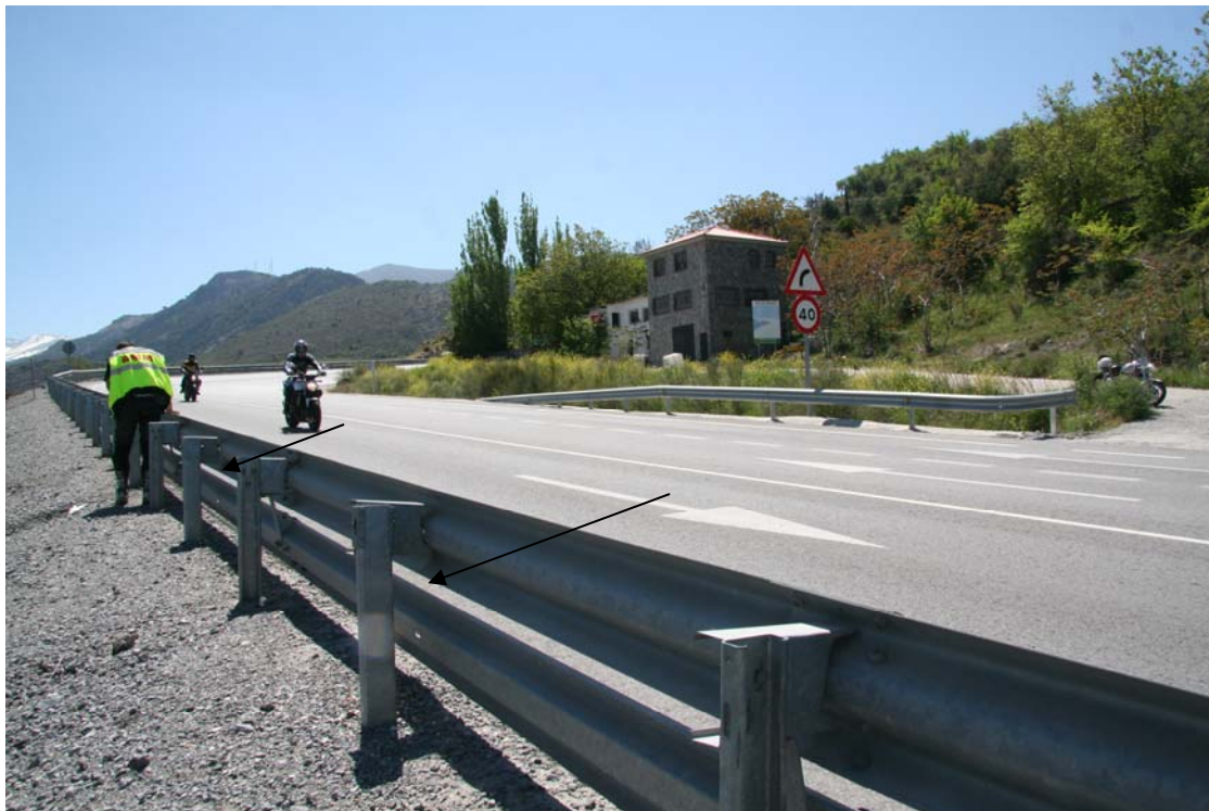
Fotografía 26. Presencia de deformaciones graves.
