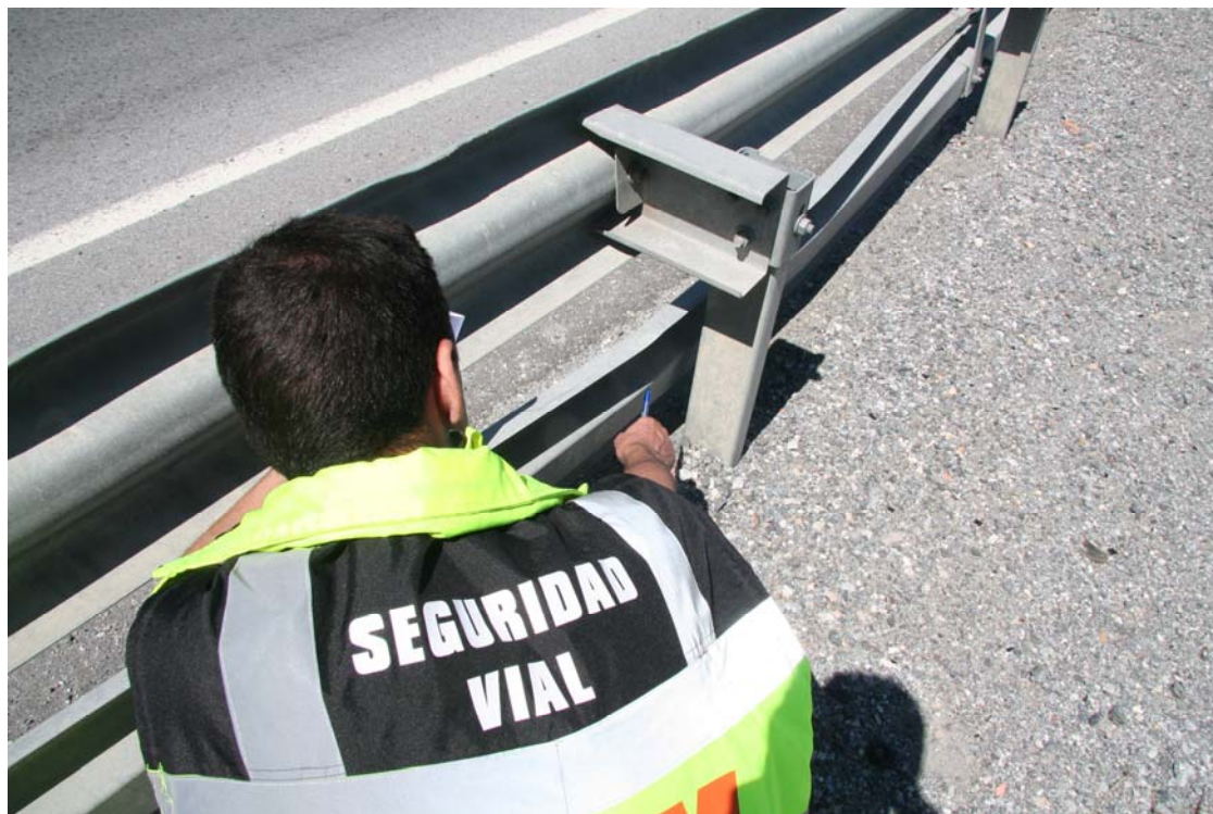
Fotografía 30. Combinación con poste tubular y poste tipo "C".
