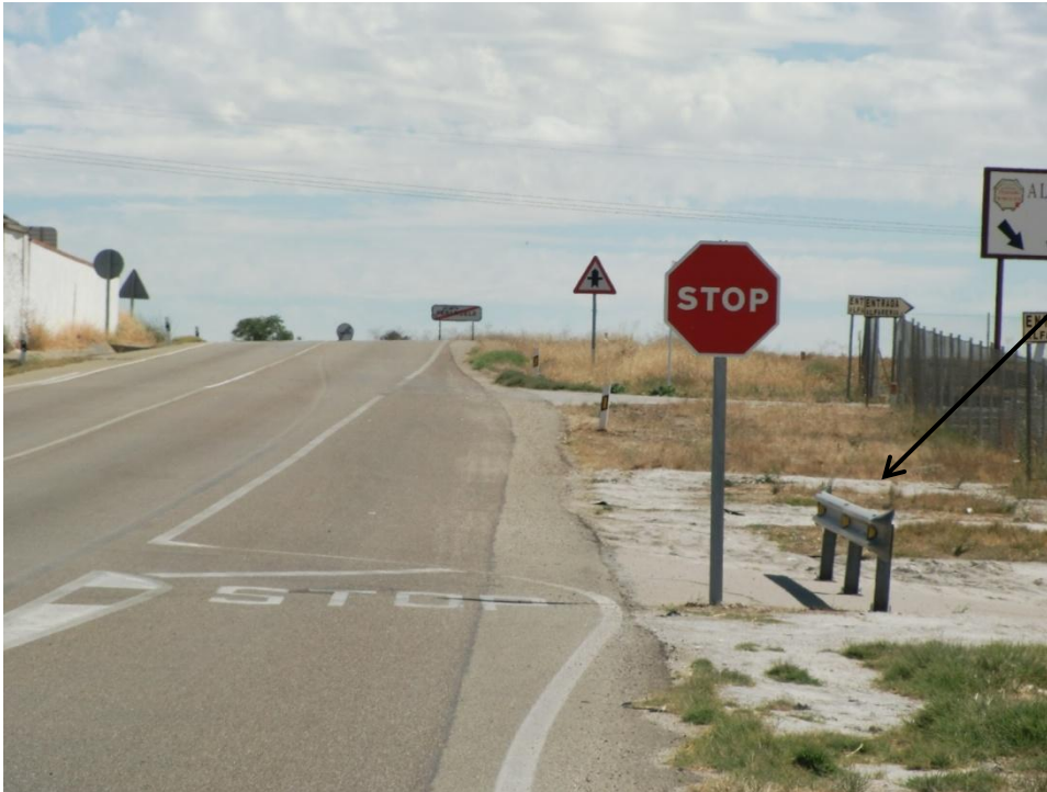
Fotografía 2. Localización detalle de la BMS.
