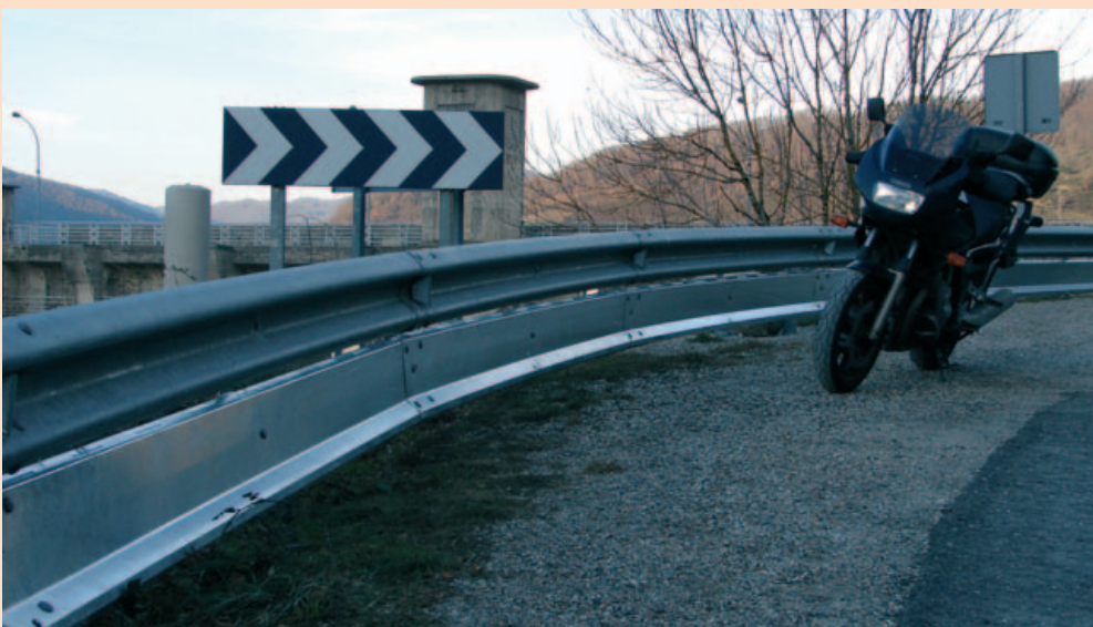
Como se aprecia, el SPM es la chapa que impide que el motorista impacte contra el poste o pase por el espacio entre la bionda y el suelo
