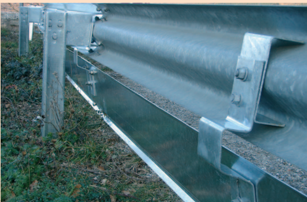
El SPM no plantea especiales problemas técnicos en su colocación, salvo que el guardarraíl o la vía estén dañados.
