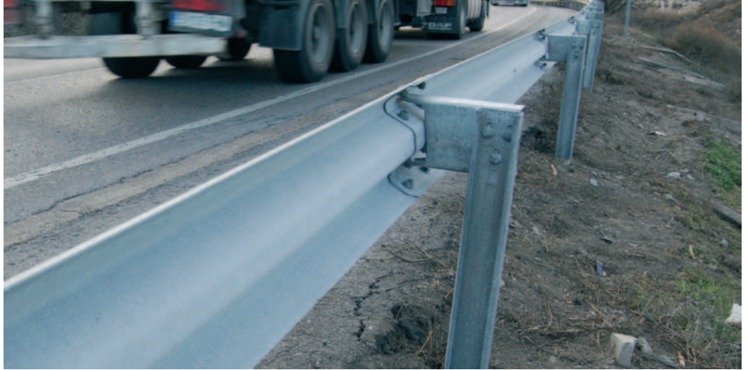
Sistema en C, ilegal y colocado a la inversa, una azaña de fomento en contra de sus propias normas
