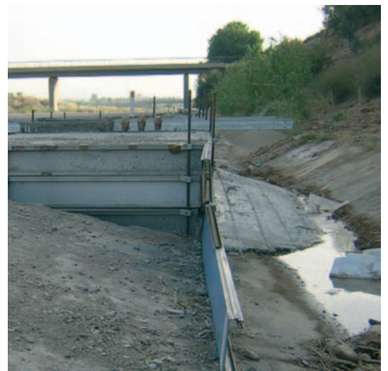
No solo nos matan las vallas, encofrado en la Autopista AP-2
