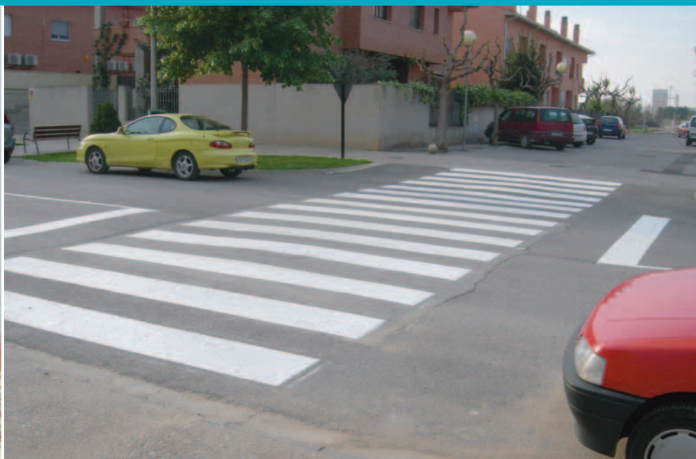
Paso para peatones que va a aparar a una calle en lugar de a una acera
