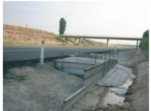
Encofrado al lado de la autopista AP 2
