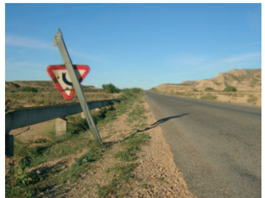
En sentido contrario curva peligrosa
