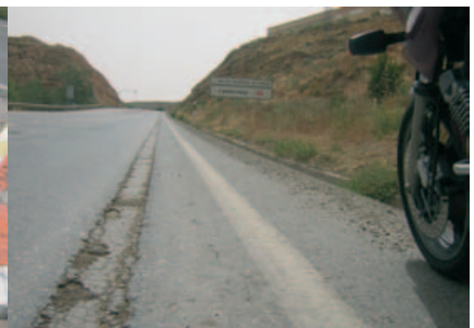
Zanja en calzada y gravilla en arcén por donde paso N-Ila
