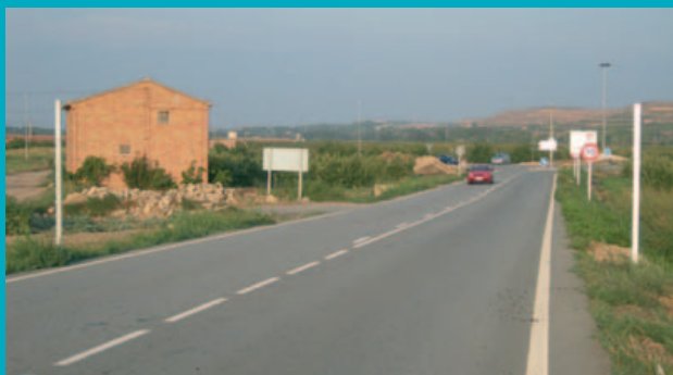
Ante Transit se denunciaron diferentes puntos de la red viaria de Cataluña por la permanencia de señalización de peligro con inexistencia del peligro, sistemas de contención altamente peligrosos y carencia de señalización vertical (Todas las incidencias denunciadas han sido solucionadas).
